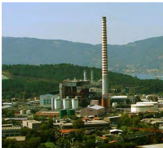
Figura 1 – Centrale ENEL “E. Montale” – La Spezia
