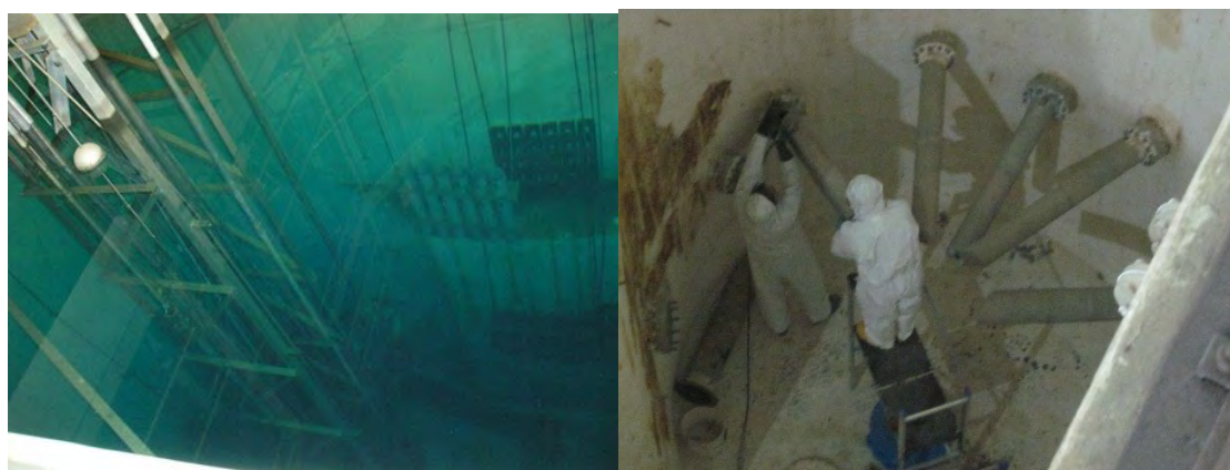
Fig. 4: Smantellamento di componenti interne alla piscina del Reattore
