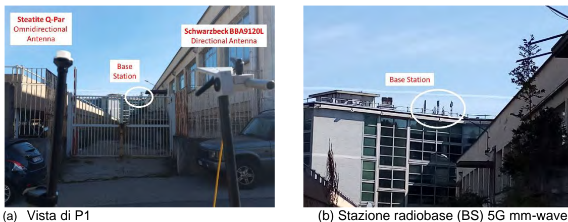
Figura 2 – Punto di misura P1 e vista della stazione radiobase (SB)
