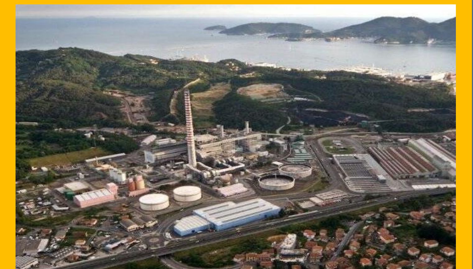
Centrale ENEL «Eugenio Montale», La Spezia (SP)
