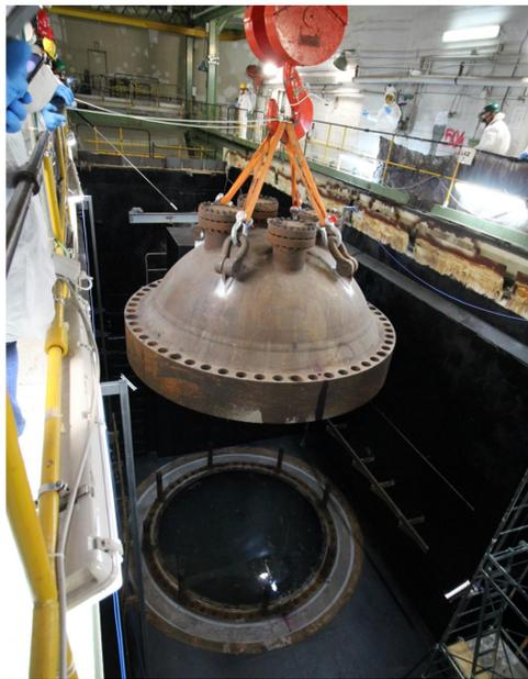
Allagamento canale reattore fino a quota + 26.00 attraverso il circuito di riempimento
